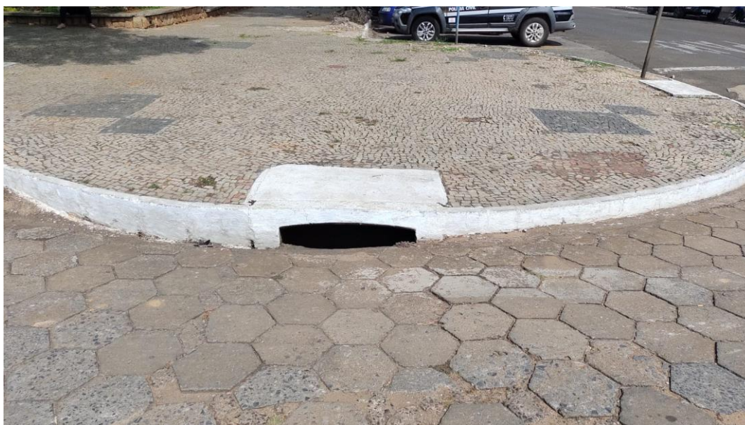
Figura 88 – Bocas de lobo sem grelha
