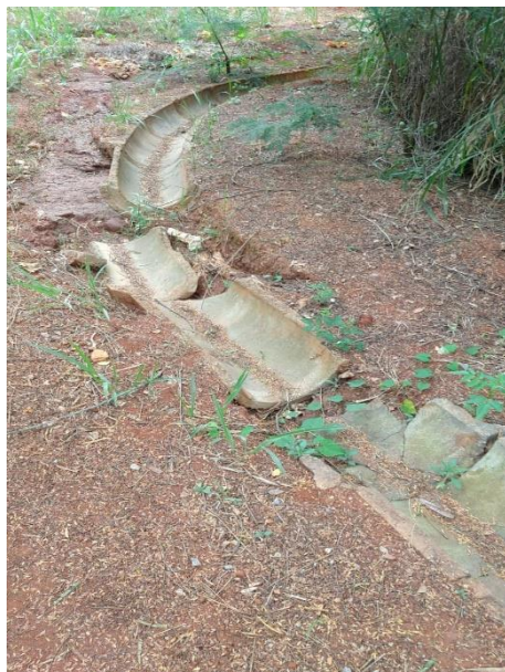
Figura 64 – Canaletas de escoamento de água da chuva
