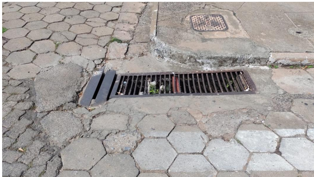
Figura 87 – Bocas de lobo com grelha
