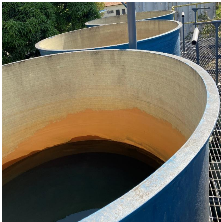
Figura 34 – Filtro (ETA de fibra)
