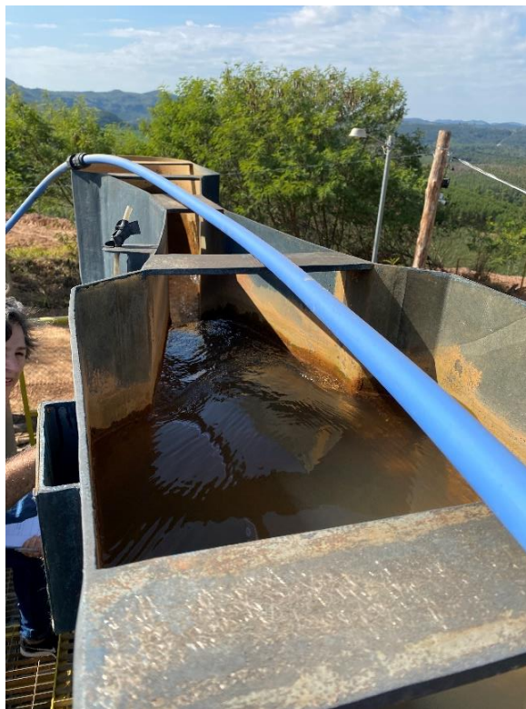
Figura 31 – Calha Parshall (ETA de fibra)
