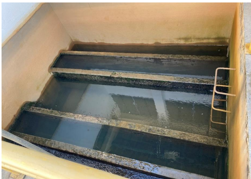
Figura 30 – Filtro (ETA convencional)
