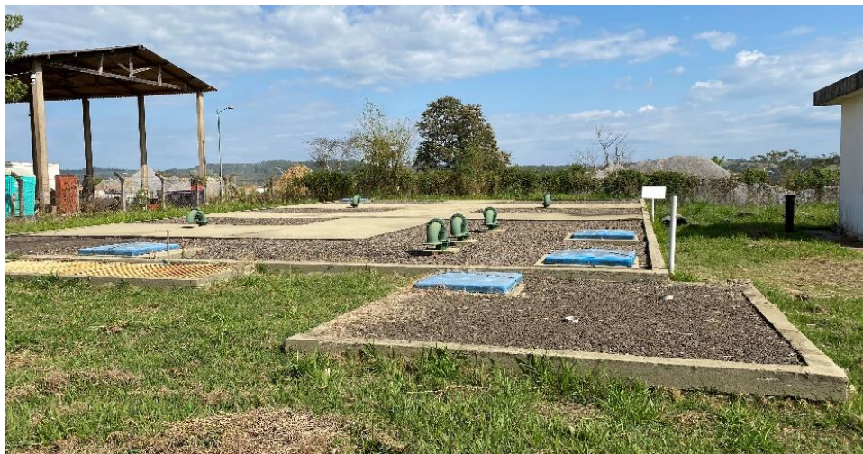
Figura 35 – Tanque de Contato das ETA's
