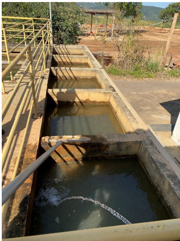
Figura 28 – Floculador (ETA convencional)
