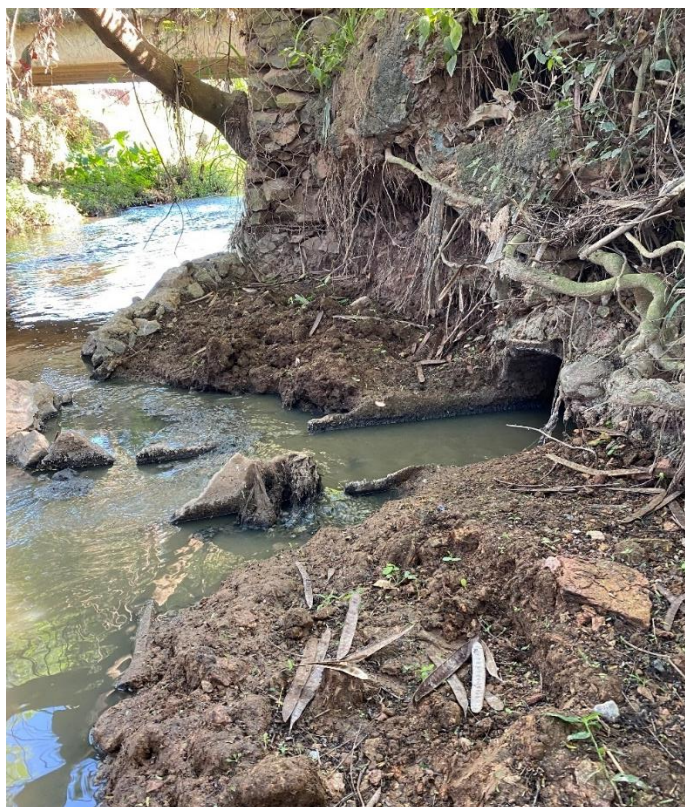
Figura 55 – Lançamento do interceptor no Córrego do Ferro
