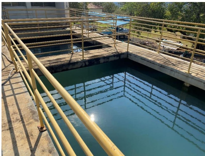
Figura 29 – Decantador (ETA convencional)
