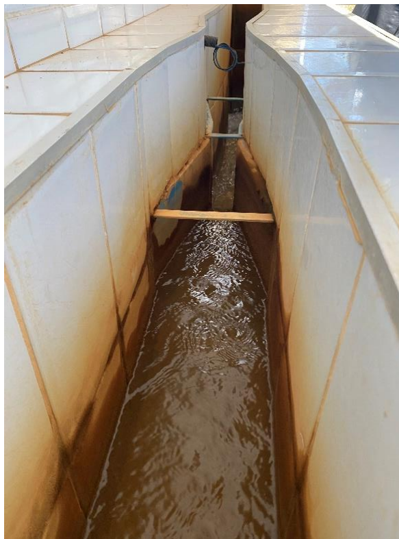
Figura 27 – Calha Parshall (ETA convencional)
