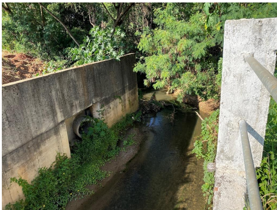
Figura 53 – Início do trecho canalizado no Córrego do Ferro e interceptor
