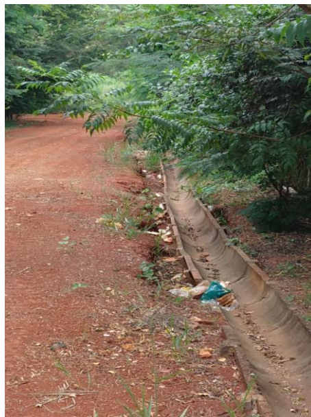
Figura 65 – Canaletas de escoamento de água da chuva
