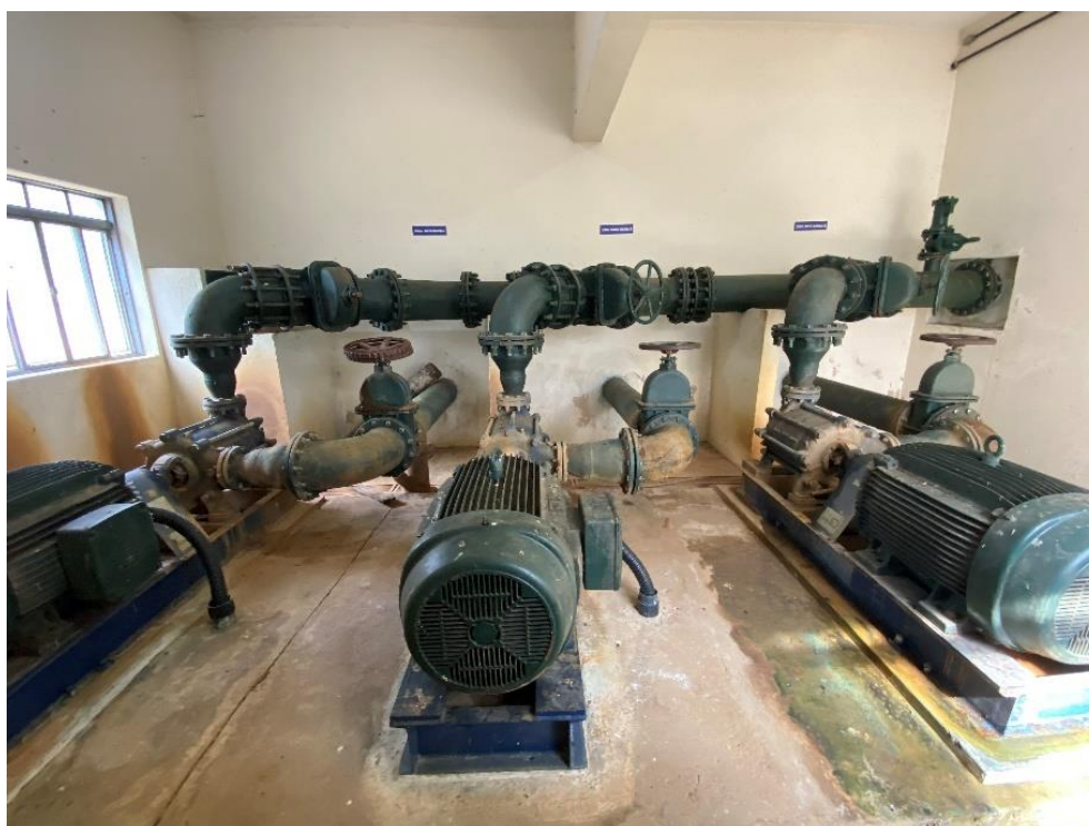
Figura 23 – Conjuntos motobomba da EEAB alto recalque
