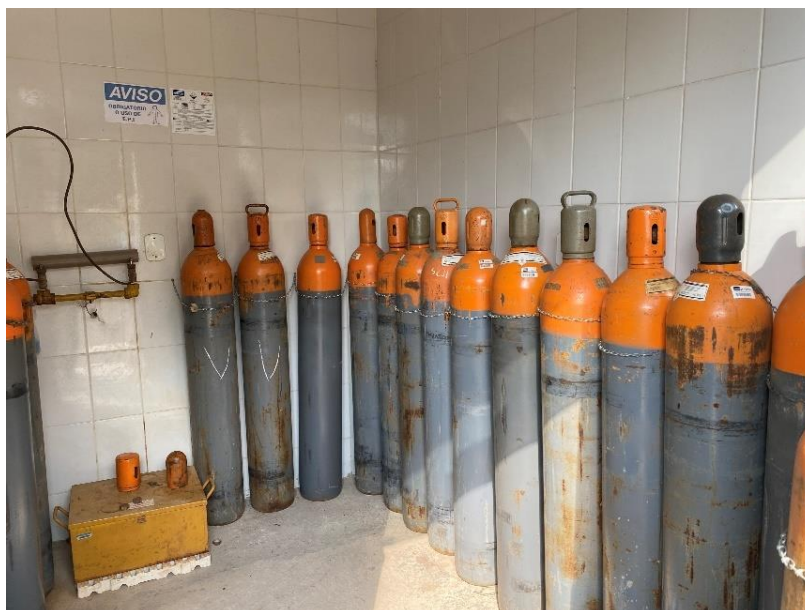
Figura 38 – Cilindros de Gás Cloro
