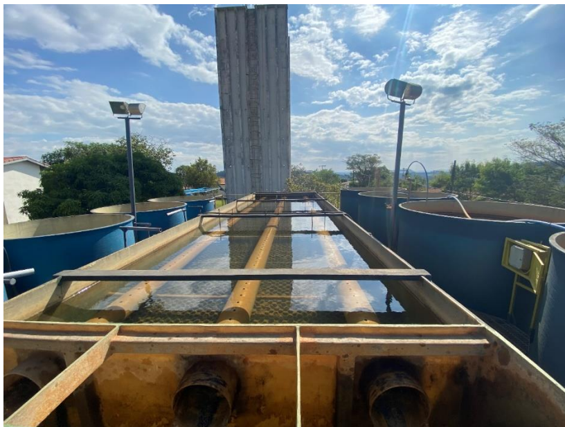
Figura 33 – Decantador (ETA de fibra)
