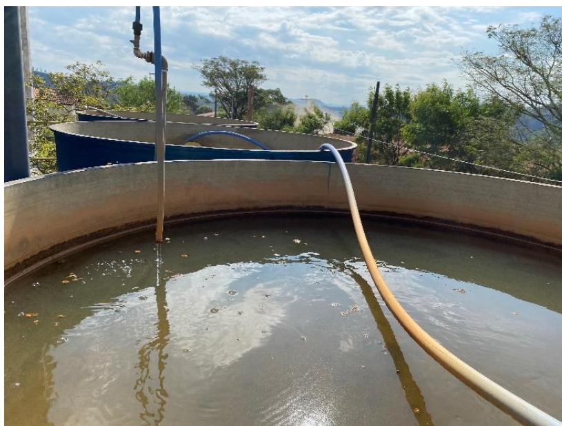
Figura 32 – Floculador (ETA de fibra)
